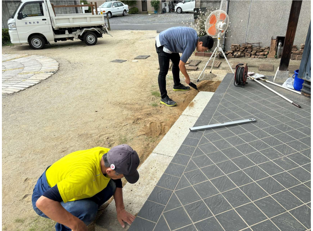
蔵の外構整備
