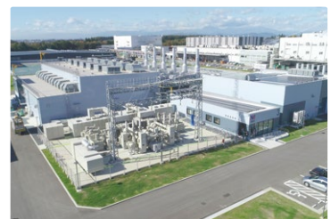
CO 2 排出削減に配慮した高効率なエネルギー供給施設
