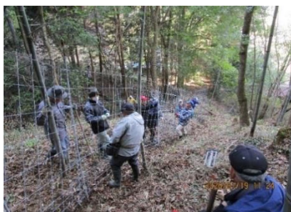
住民による防護柵の設置
