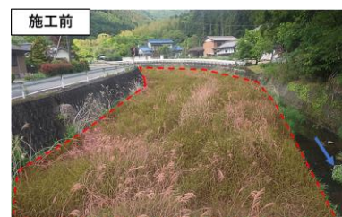
▼堆積土除去の施工事例
