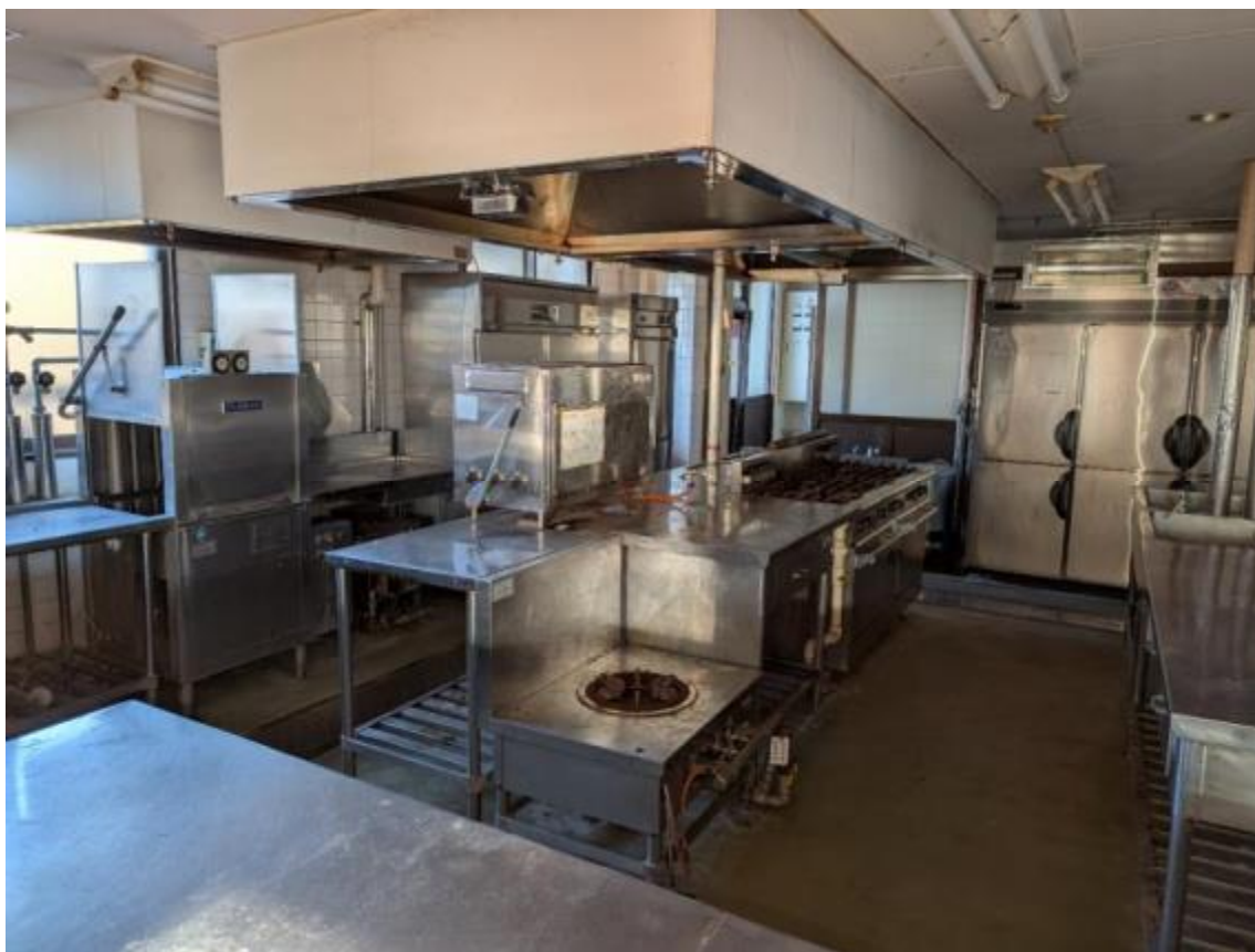
本館⑦（1階厨房）
