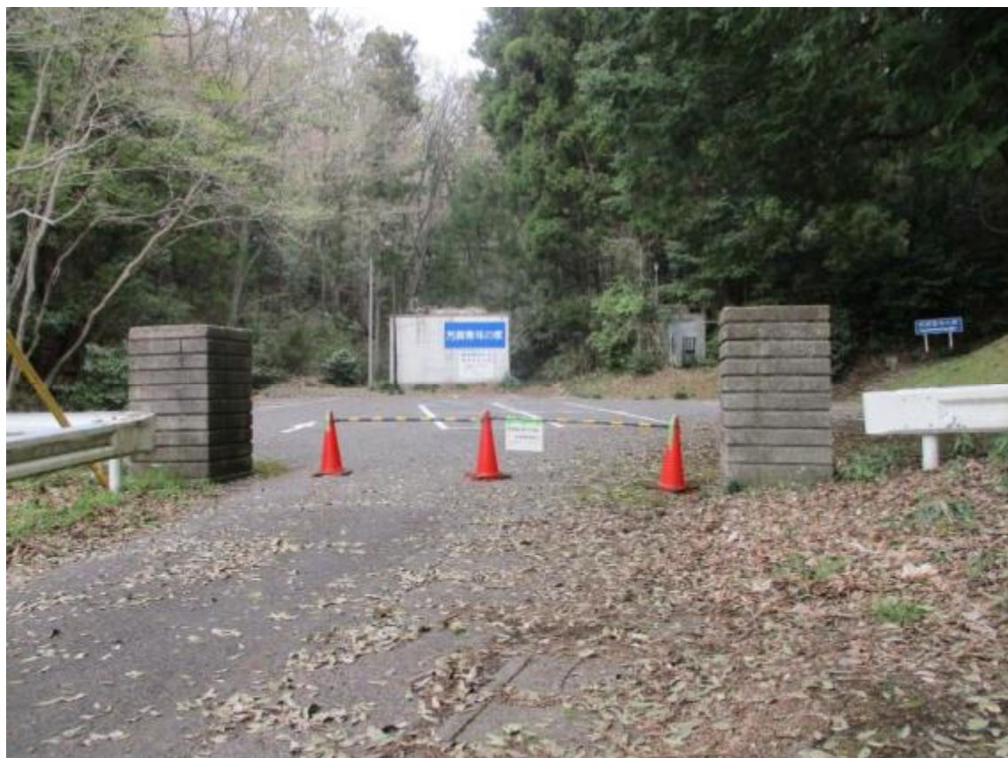
駐車場及びポンプ小屋等（敷地西側）
