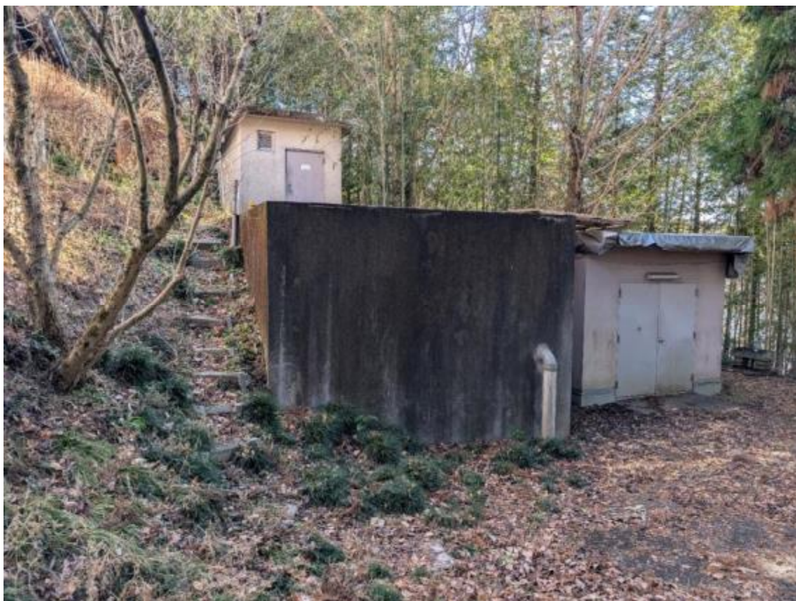
浄化槽小屋・物置（体育館西側）
