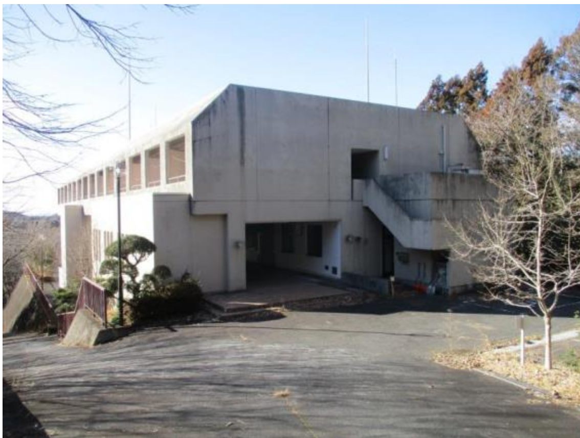
本館①（東側外観・正面玄関）
