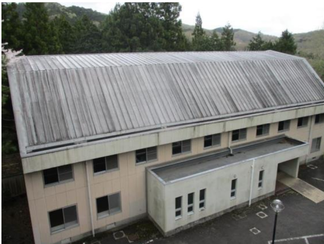
体育館①（北側外観）
