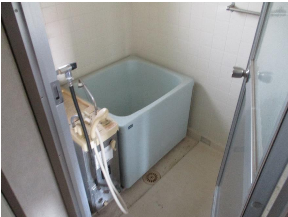
建物内にて撮影（浴室）
