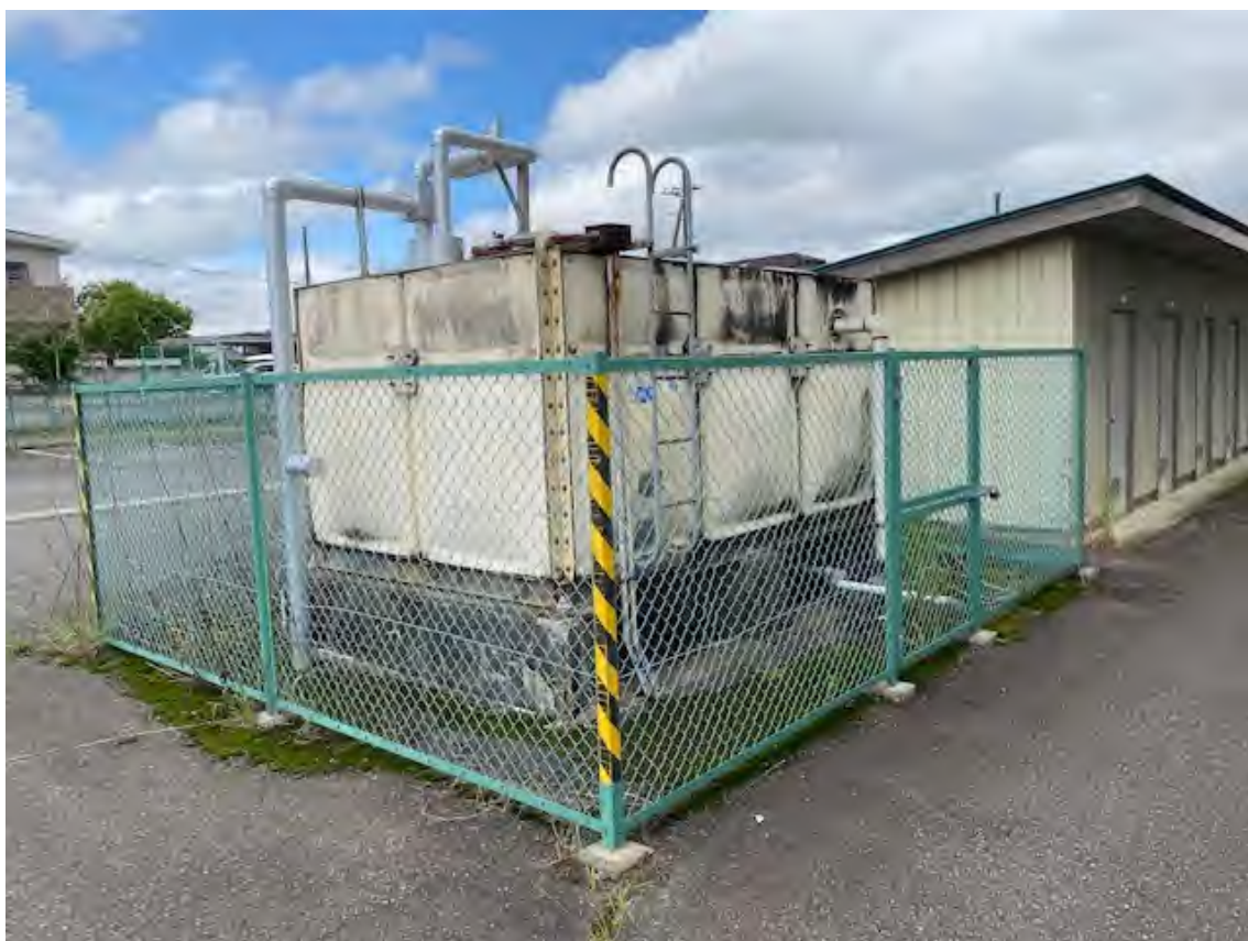
敷地北西側（受水槽）
