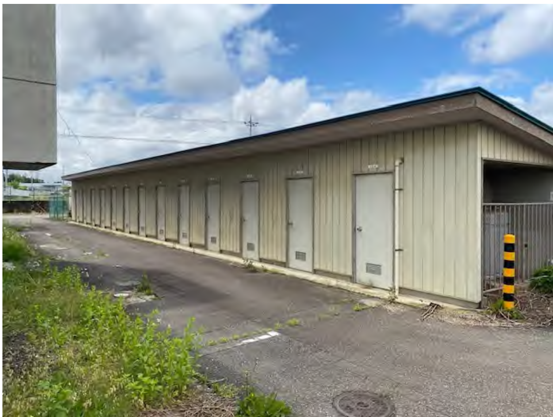
敷地北側（物置・プロパン庫）
