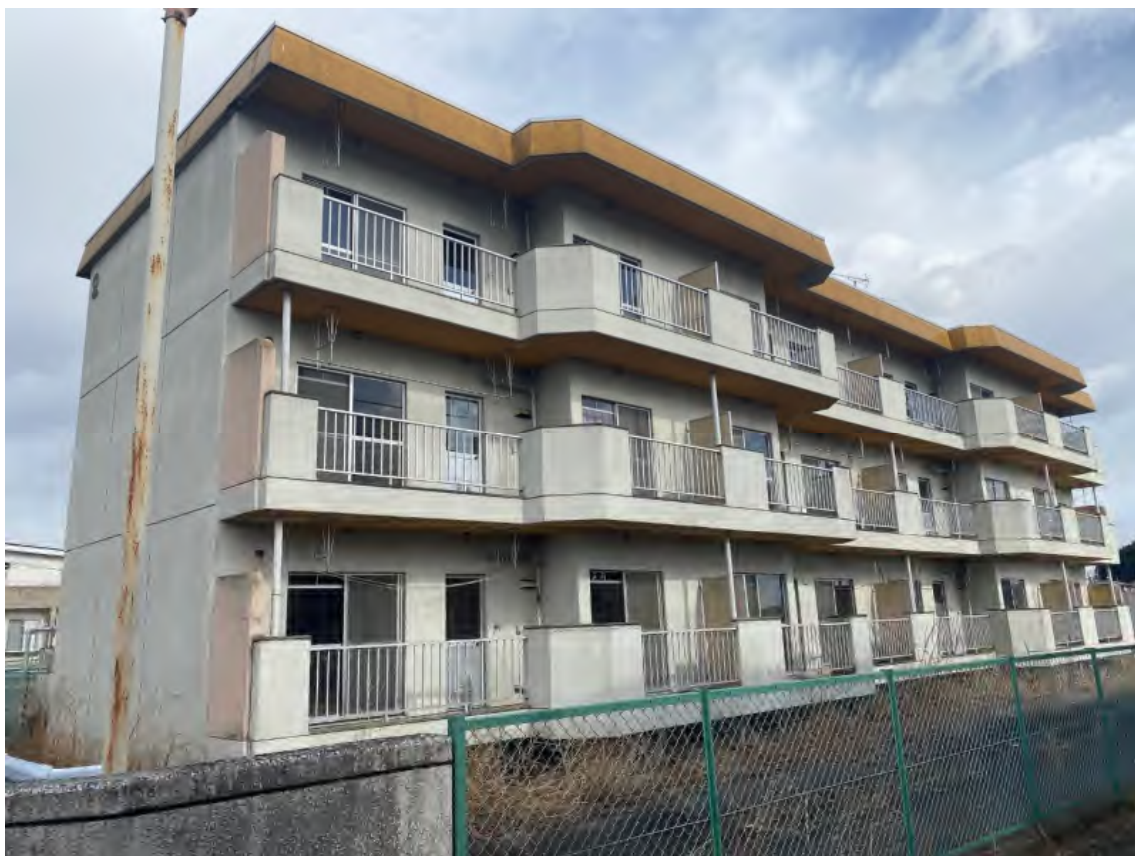
南西側から北東側を見て撮影
