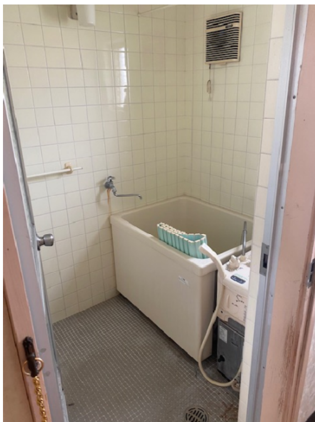
建物内にて撮影（浴室）
