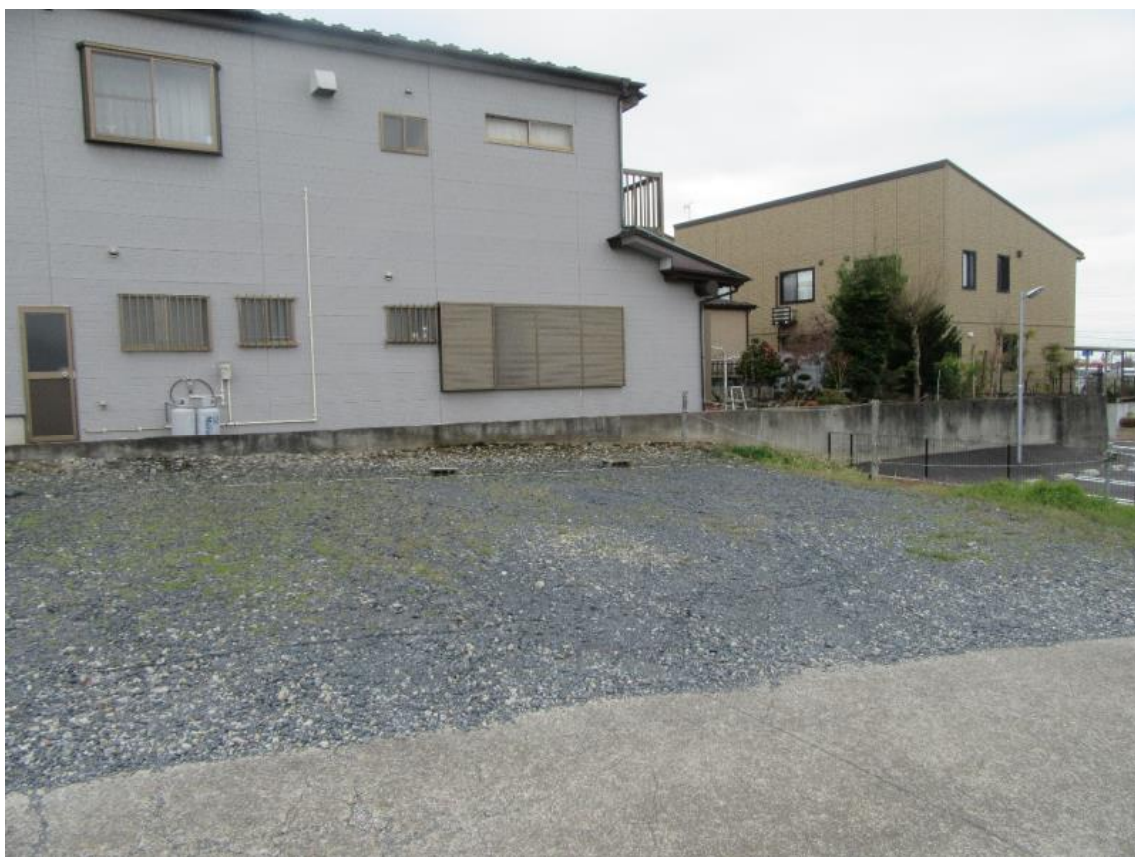
北西側から南東側を見て撮影
