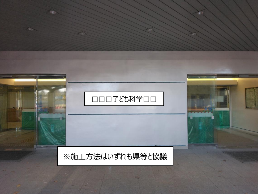
⑤本館正面入口（壁面）・・・1か所（愛称看板）
