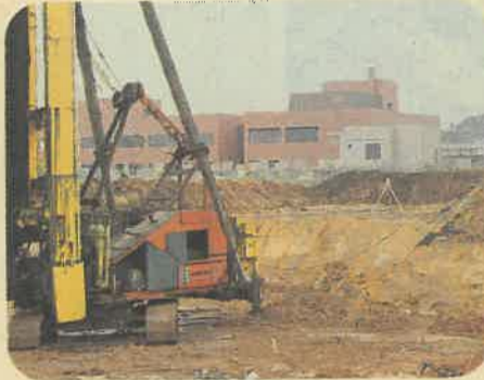
建設進む、下水道処理施設
