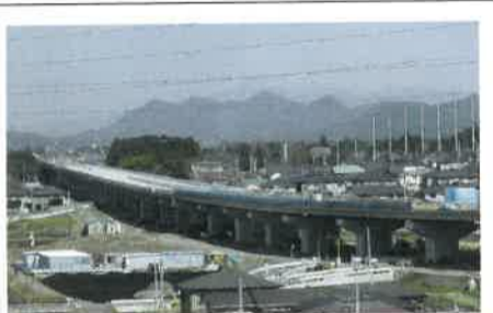
建設のすすむ宇都宮北道路。宇都宮環状道路と東北自動車道の宇都宮インターチェンジを結びます
