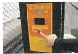
スーパー防犯灯 ボタンを押すとサイレンと回転灯も作動
