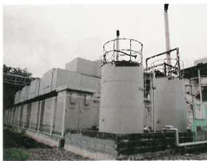
コマツでは、省エネ機器を積極的に導入。発電時に余った熱から蒸気をつくります
