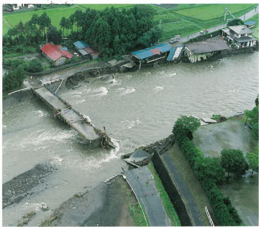
平成10年8月末豪雨災害 余笹川(那須町/中余笹橋)
