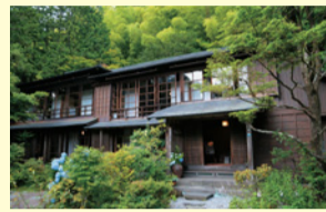
別名「侍屋敷」と呼ばれた建物
