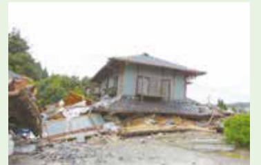
熊本地震で倒壊した住宅(熊本地震における建築物被害の原因分析を行う委員会報告書から)
