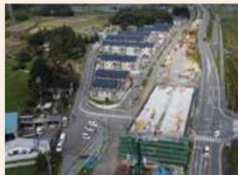
▲バイパス工事の様子
