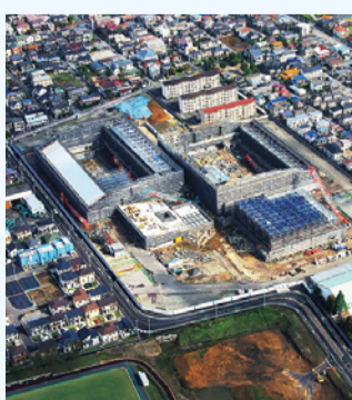
建設工事中の新体育館・屋内水泳場
