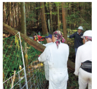
住民で協力して行うフェンスの修理
