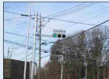
自転車専用信号機の設置例
