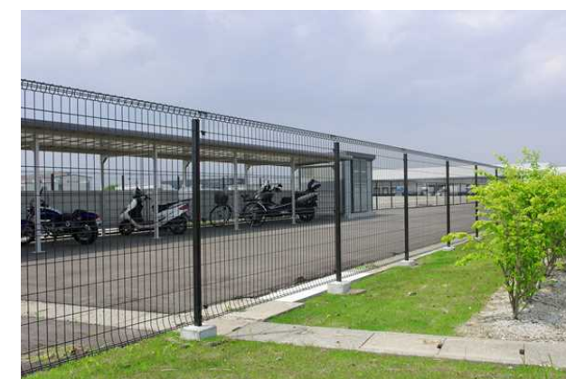
鋼製メッシュ柵設置イメージ
