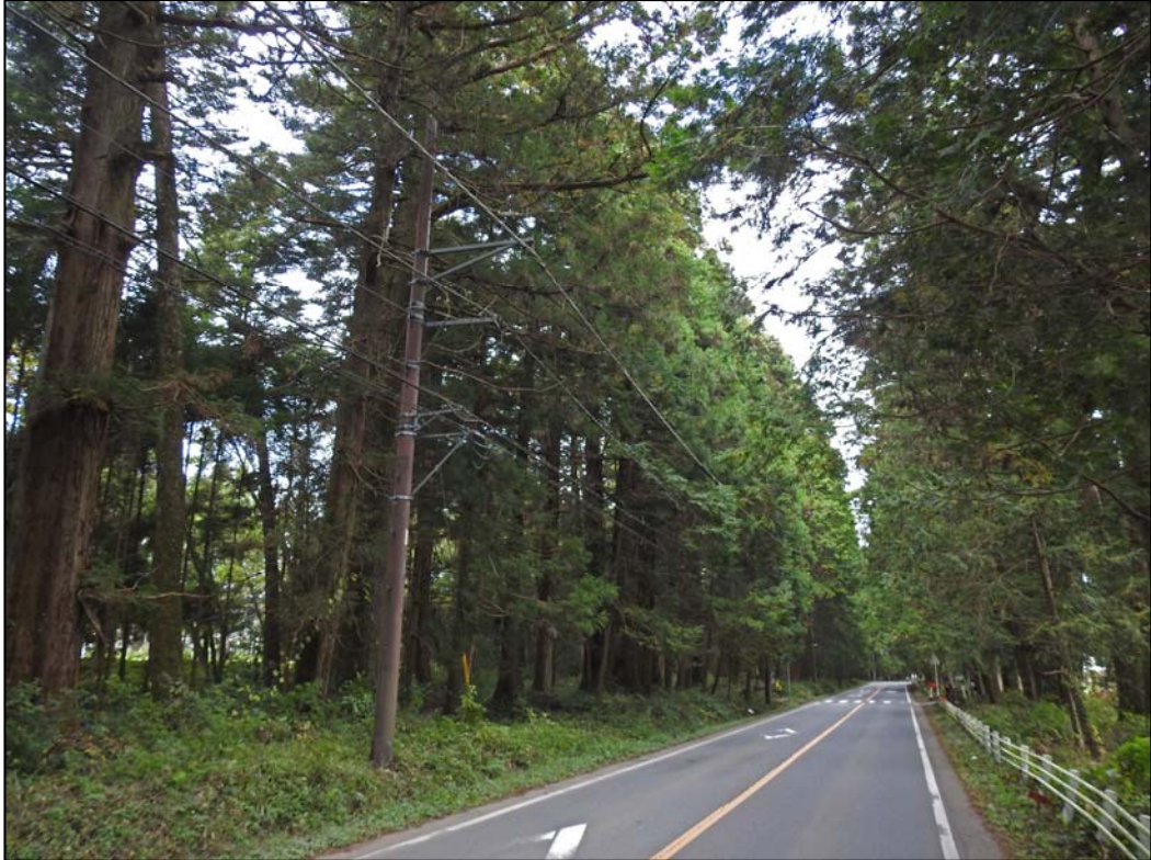
景観に配慮した電柱（会津西街道・倉ヶ崎）
