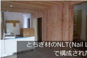
とちぎ材のNLT(Nail Laminated Timber)で構成された賃貸住宅
