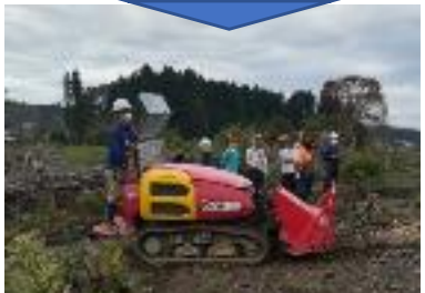
機械による地拵え・下刈り
