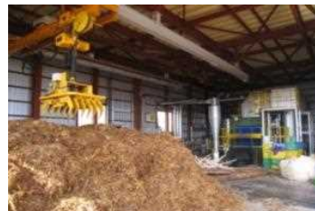
<バイオマス利用施設> 熱源用木質焚きボイラー
