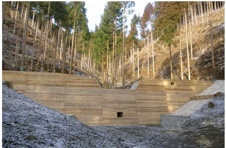
雪害木を整理し流木防止と土石流の発生を抑える治山ダム
