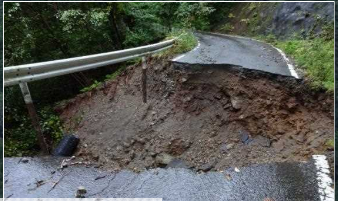
林道の被災状況
