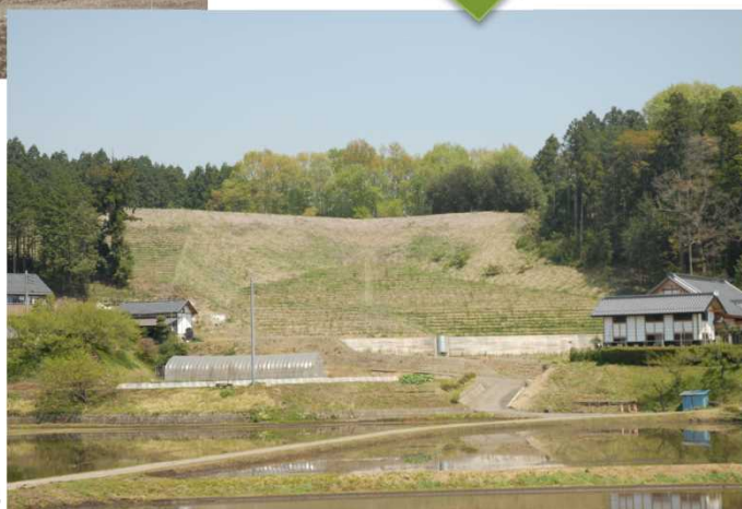
復旧工事が完了した林地
