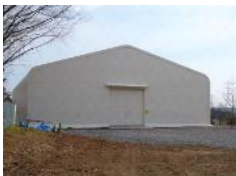
飛散防止大型テント(下水処理場敷地)
