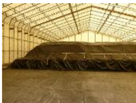
熔融スラグ等の保管(テント内部)
