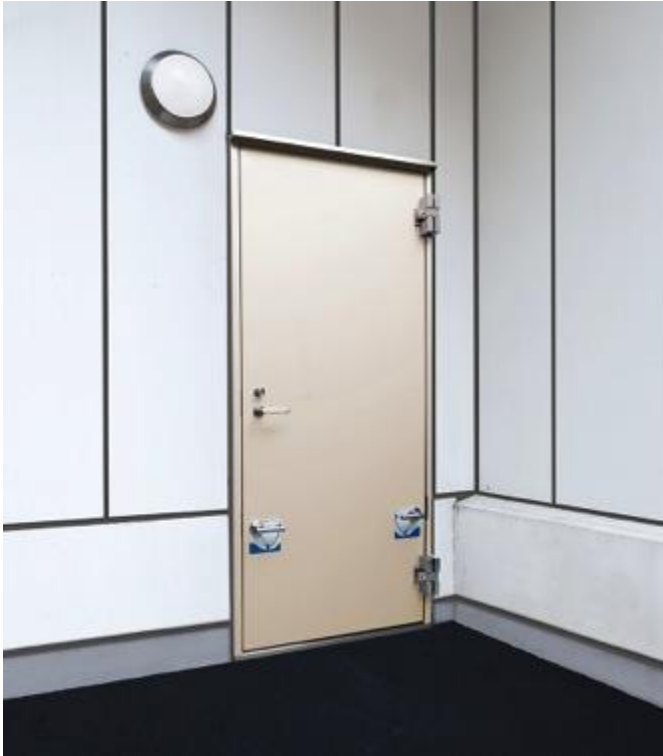
止水グレモン：ロックするだけで漏水を防止
