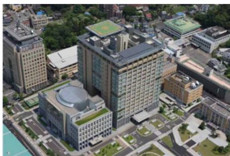
図5-2 空から見た県庁舎（太陽光発電設備・屋上緑化）
