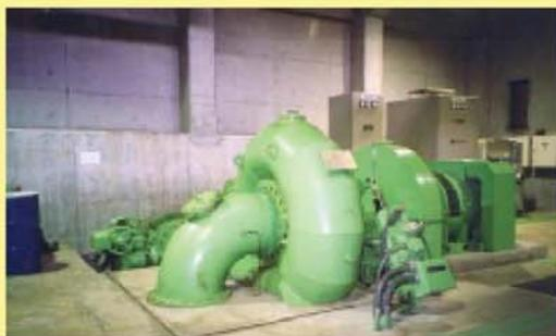
急峻な地形を活用し、那須野ヶ原用水に設置された小水力発電施設を見学することができます。エリア内の3箇所ですべて7基の発電機が稼働しており、農業用水を利用した「エネルギーの地産地消」の好例となっています。
