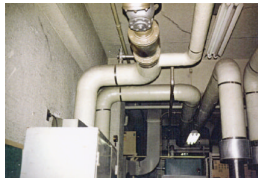
吸音・断熱（機械室、壁・天井）
