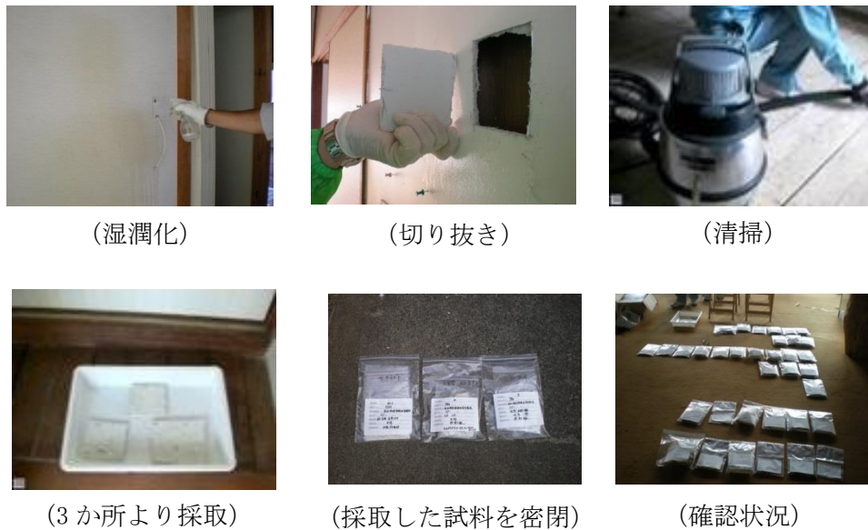
図 I - 5 - 8 サンプルング例 (成形板)
