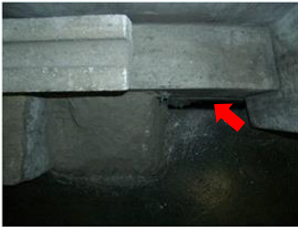
（参考資料）写真6-8 スラブ層間塞ぎ 充填材なし
