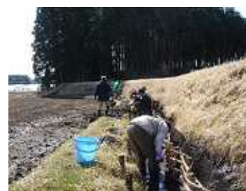
水路の泥上げ
