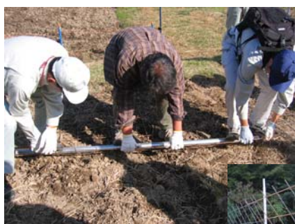
鉄パイプを使った折り曲げ
