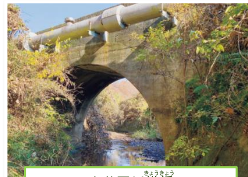
小井戸川拱橋
