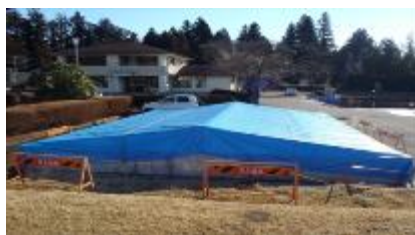
(天日乾燥床をブルーシートで被覆)
