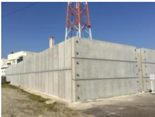
ボックスカルバートの設置
