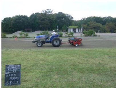
目土散布（機械）状況
