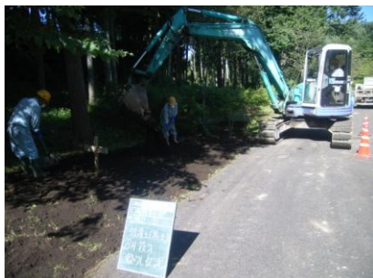
覆土（機械）状況
