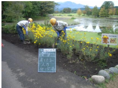
覆土（人力）状況
