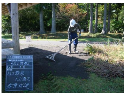
目土散布（人力）状況
