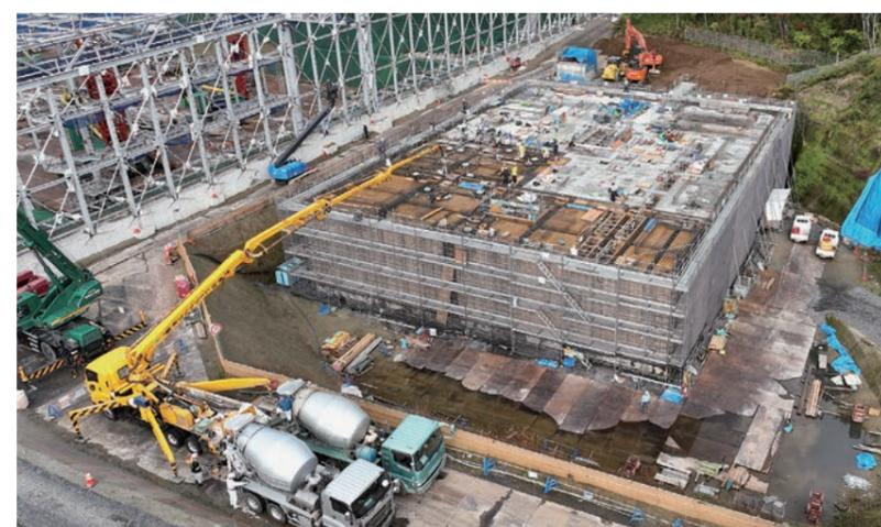
埋立地の浸出水を一時貯留し、処理するための水槽を作っています
