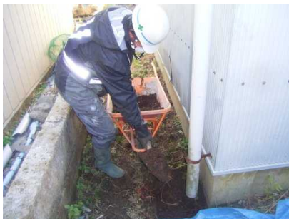
雨樋下除染作業中
