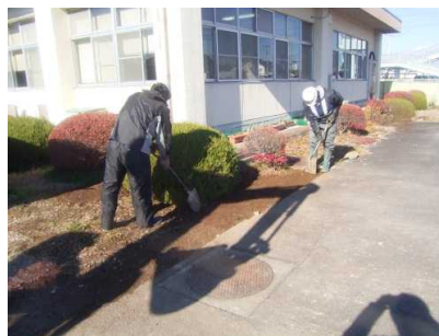
アスファルト横除染作業中
