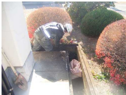
側溝内汚泥の除去作業中
