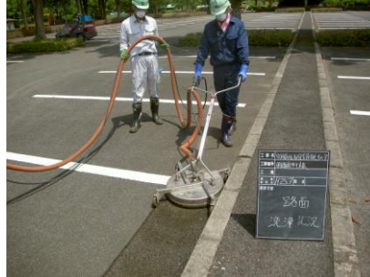
路面洗浄状況
