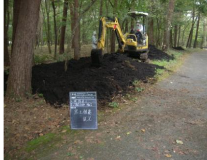
覆土（機械）状況
