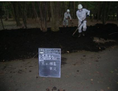
覆土（人力）状況
