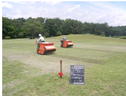
目土散布（機械）状況
