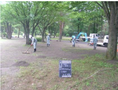
目土散布（人力）状況
