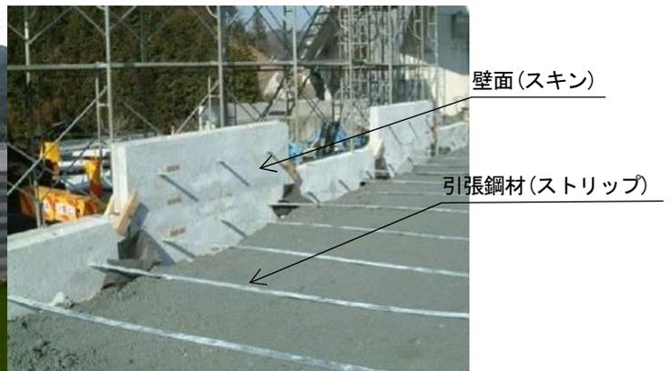
写真-2 補強土壁の施工例2
