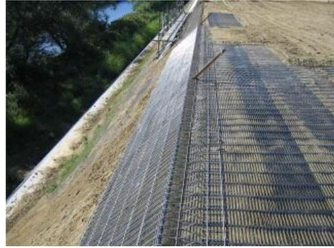
写真-3 補強盛土(ｼﾞｵｷﾞｽﾀｲﾙ)の施工例 2
