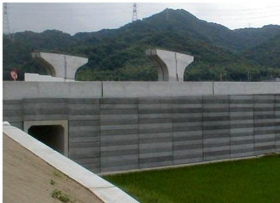
写真-2 補強土壁の施工例1
