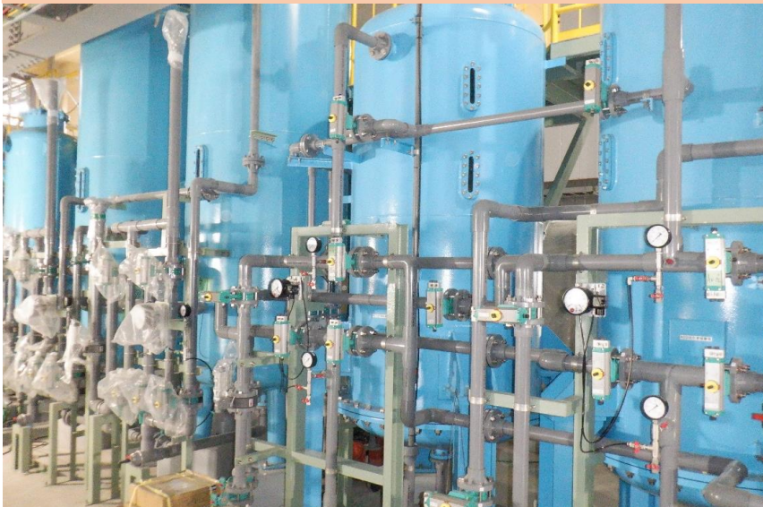
③ 浸出水処理施設内のプラント工事状況
