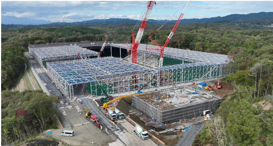
③ 浸出水処理施設の地下水槽工事の様子
