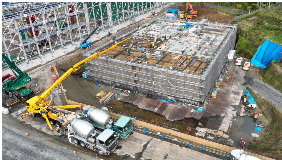
③ 浸出水処理施設の地下水槽工事の様子
