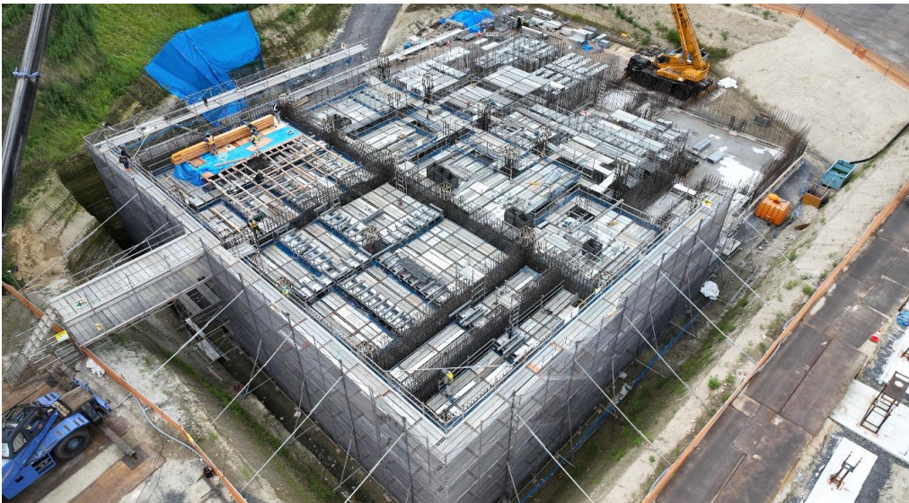
③ 浸出水処理施設の水槽築造作業の実施
