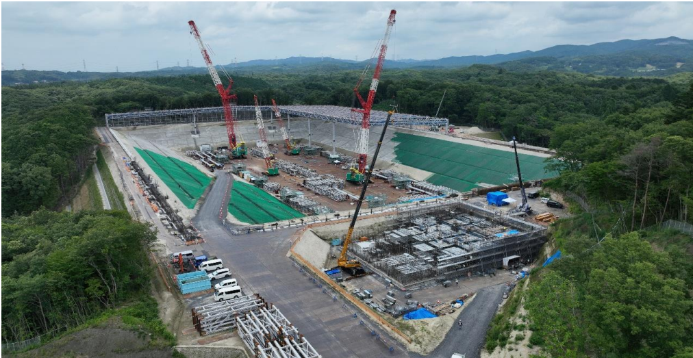
③ 浸出水処理施設の水槽築造作業の実施
