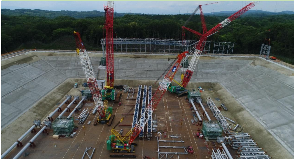
③ 埋立地（被覆施設）の鉄骨組み立て作業の実施
