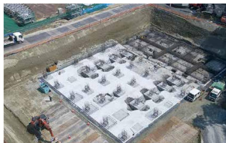
廃棄物から出る浸出水(汚水)を貯留するプールを築造しています
