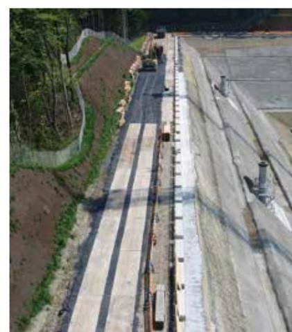
被覆施設の外周基礎コンクリートを施工しています
