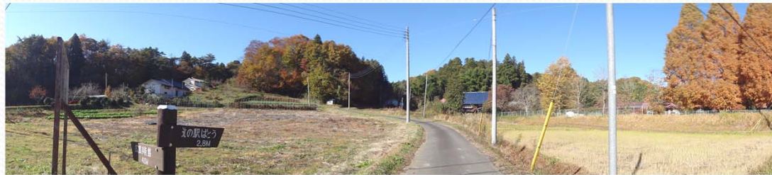
【現況（和見側南東地点）】
