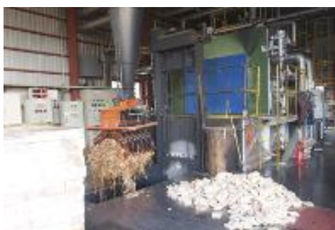
上：とちぎの木材の優良な点を原木をみながら説明する二ノ宮社長 中：多種の製材品が大量に在庫されている 下：工場から出た端材や皮を木屑吹きボイラーで焚き、乾燥機の熱源として循環利用する
