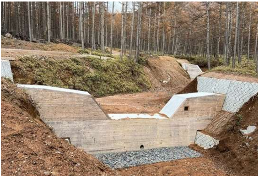
図-10 残置式間伐材型樁 三本松 (日光市)
