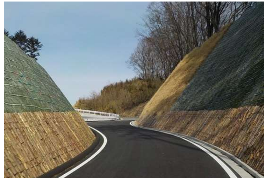
図-11 丸太伏工 林道塩の草須佐木線 (大田原市)
