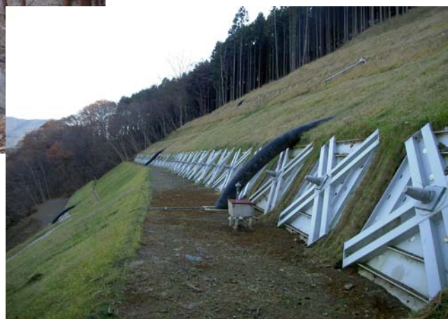
地山の移動を抑えるアンカー工工事（鹿沼市）
