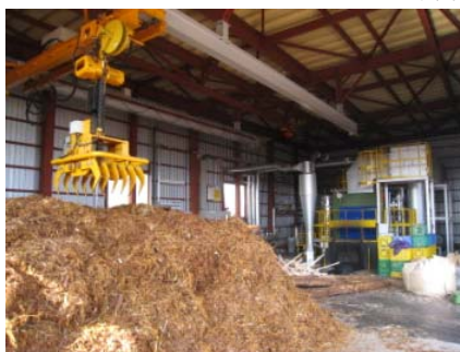
木質焚きボイラー
