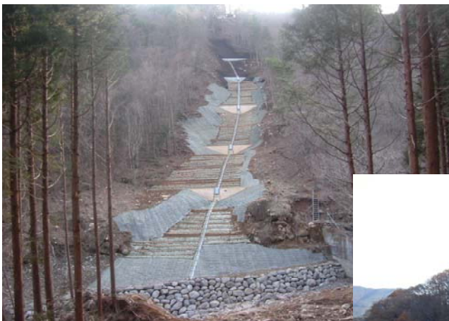
崩壊地の土砂崩れを抑える土留工工事（塩谷町）
