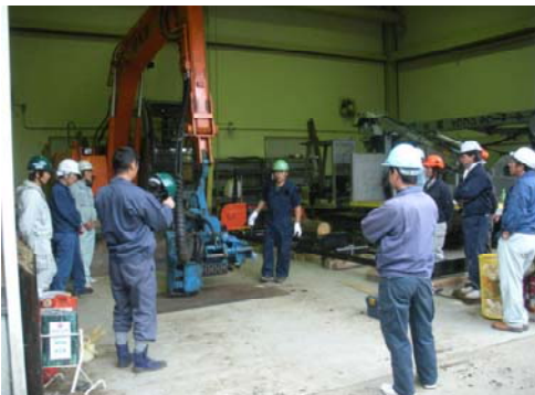
車両系建設機械の実地研修（鹿沼市）
