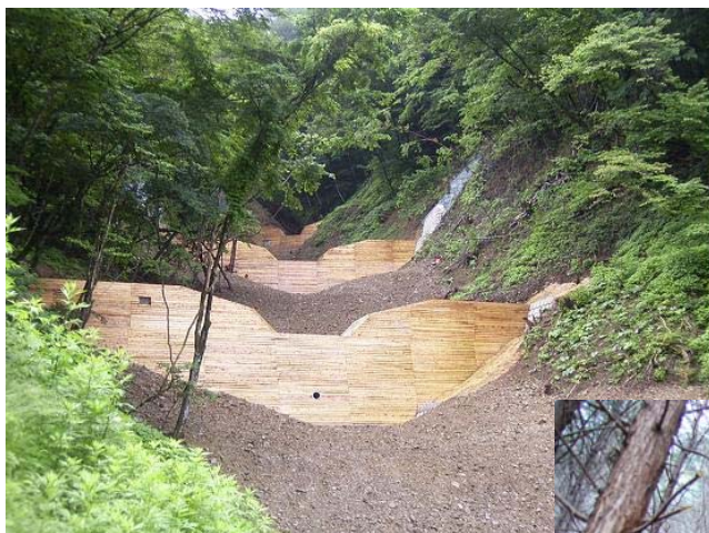
溪流に堆積した土砂の流出を止め、土石流の発生を抑える治山ダム工事（那須塩原市）
