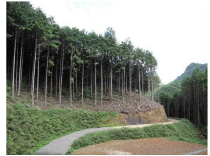
林道の整備状況（日光市）
